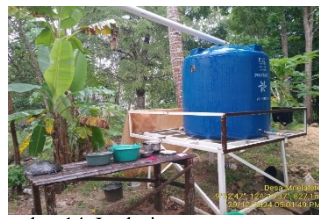
ambar 14. Instalasi terpasang
