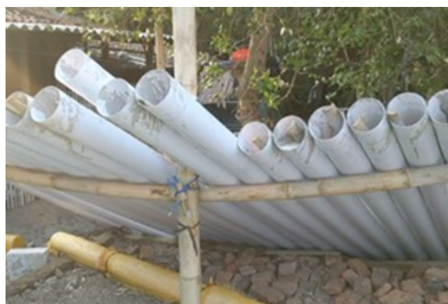
Gambar 3. Hasil Pengecoran Pipa
