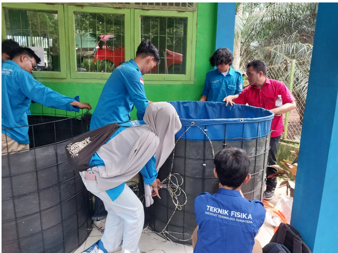
Gambar 1. Instalasi 2 Unit Kolam Bioflok dengan IoT
