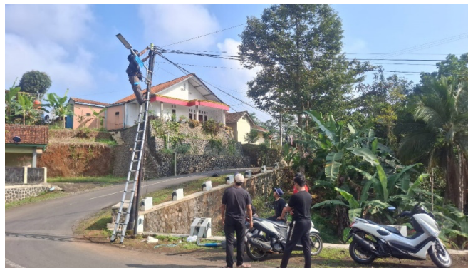
Gambar 6. Pemasangan Lampu Penerangan Jalan
